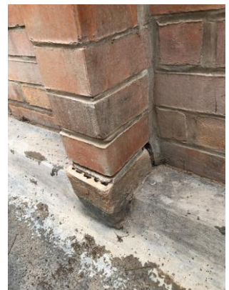
塀の下部の破損は雨季の大雨で崩れるかもしれません。
