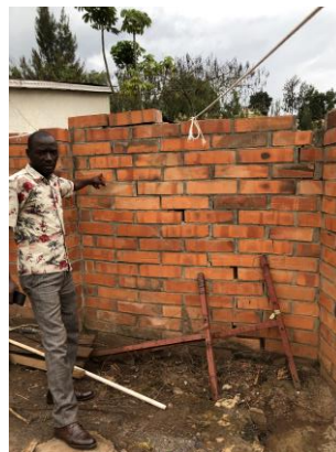
塀の下部の破損は雨季の大雨で崩れるかもしれません。
