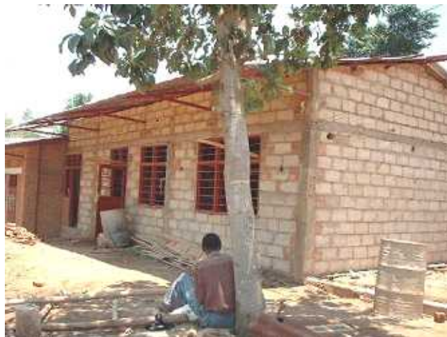
屋根取り付け後の教室外観
